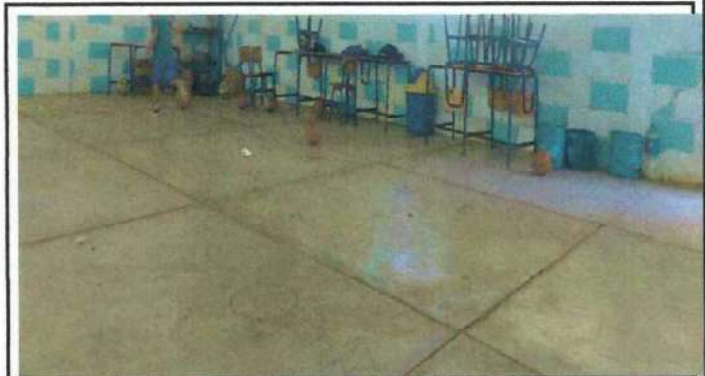
Foto 4: sustitucion de piso de torta de concreto
