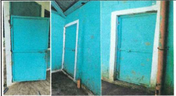
Foto 2: Mantenimiento a estructura lijado, cepillado,, aplicación de pintura en puertas) 1.08 mts x 2.08mts y susticcion de una puerta
