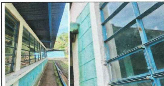
Foto 5: Mantenimiento a estructura de metal de ventana
