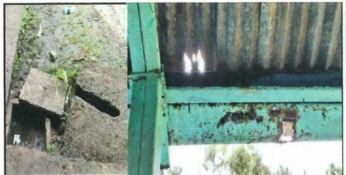
Foto 6: se nesecita instalar canales de vajada de agua pluvial y reparacion de tuberia
